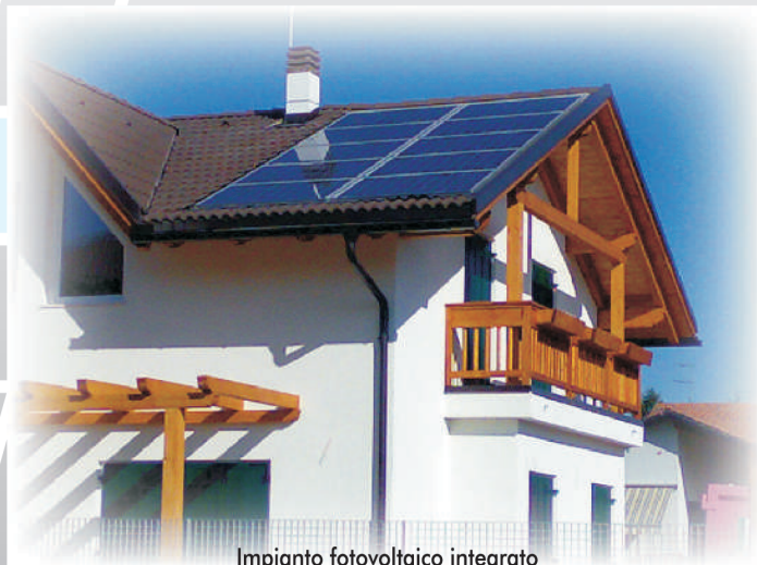
Impianto fotovoltaico integrato
